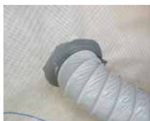
Sigillatura di tubi per cappe.
