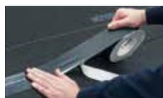
Per incollare permanentemente teli da sottotetto, barriere al vapore e barriere regola - vapore. Adatto a sigillare ed incollare ermeticamente sovrapposizioni dei suddetti teli. Ideale anche per incollare a tenuta ermetica giunti di pannelli OSB accoppiati.
