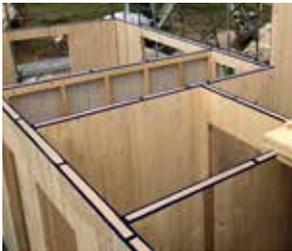
Applicare lungo il perimetro delle pareti in costruzioni in legno in modo da separare le pareti e il solaio sottostante
