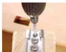
Inserire la prima vite nel foro di centraggio. Il giunto deve essere a filo del bordo superiore della trave secondaria.
