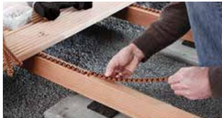
Se necessario, i listelli distanziatori possono essere anche collegati. Così il fissaggio delle tavole viene fatto esattamente al centro sulla trave della sottostruzione.
