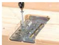
Fissare il maschio del giunto nella fresatura praticata sulla trave principale.
