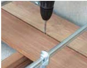
La seconda asse va appoggiata contro la prima con l'aiuto di uno strettoio. Successivamente si fissa la lamella con una vite. Ripetere l'operazione fino a completamento.
