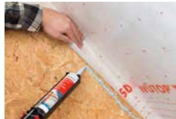
**Per la sigillatura permanente di tutti i giunti di connessione in ambito di tenuta all'aria e al vento e per il montaggio dei serramenti in ambiente interno ed esterno.**
