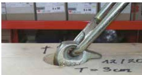
Fresatura: profondità 3 cm / diametro 7 cm
