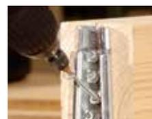
Inserire le viti in tutti i fori rimanenti. Avvitare a 35° come proposto dalle alette inclinate.
