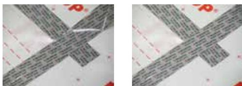
I **giunti longitudinali** (quando il nastro viene prolungato) devono essere fissati con un incollaggio trasversale.
